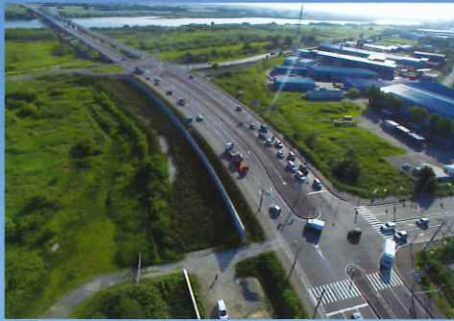
一般国道275号 江別北道路 (令和5年8月8日4車線開通)
