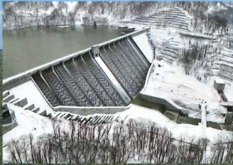
幾春別川総合開発事業 新桂沢ダム試験湛水サーチャージ水位時 (令和5年12月16日撮影)
